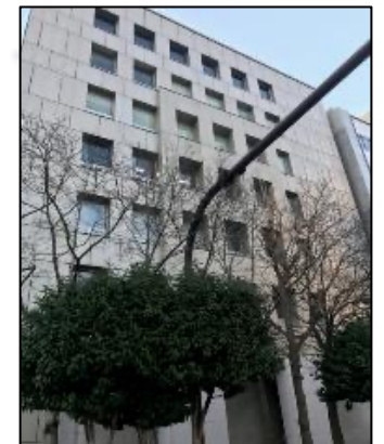
名古屋BIMセンター
