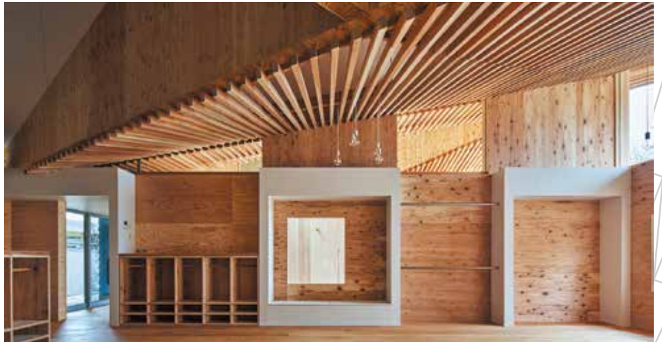
平野さんはこのプロジェクトで、BIMをはじめて活用した。「外注でBIMに詳しい設計士を入れて、教わりながら進めました。斜めの屋根に対して斜めにあたる部分などの形の操作とか、フレームがどうなるのか、どういう風に切断すればよいのかとか、すべて Archicad 上で描けたので、BIMを使わないと大変だった案件かも」。
