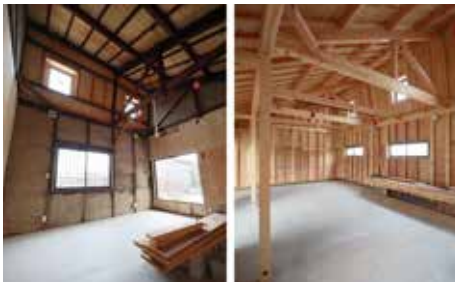
工事現場。以前の木組み構造はできるだけ再利用した(左)。増築部分は以前の木組み構造とそっくり設計した(右)
