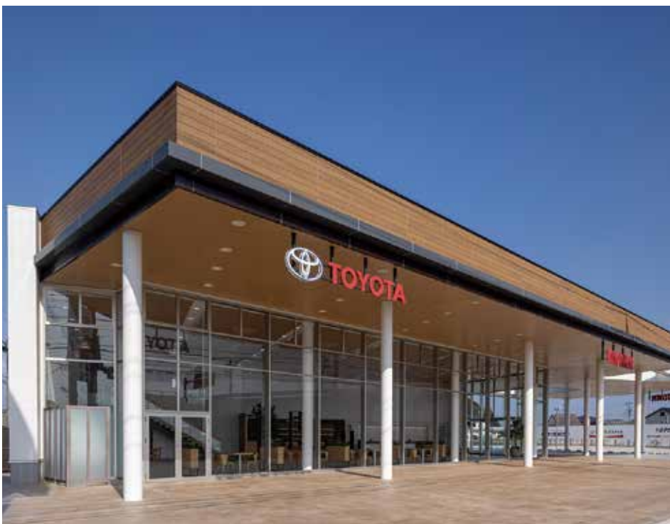
ディーラー店舗の完成写真（南面外観）
