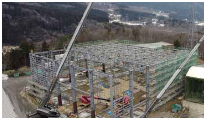
現場施工状況
