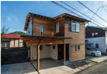
初のBIMプロジェクトとして竣工した「小白川にある家」
